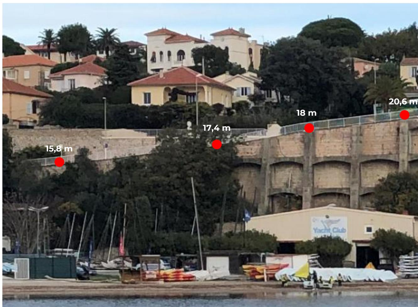
Figure 31 : Photographie hauteur du mur de soutènement
