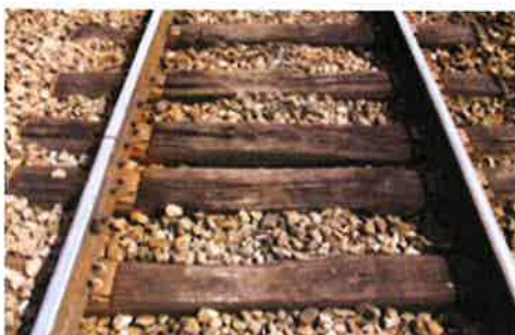
Figures 1 : Rails courts sur traverses bois & Longs Rails soudés sur traverses béton
