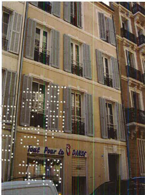
**Le bâti** : Les murs, épais de 40 cm, sont en moëllon de calcaire, recouverts à l'intérieur d'un enduit plâtre de 2 cm et à l'extérieur d'un enduit à la chaux de 3 cm.
