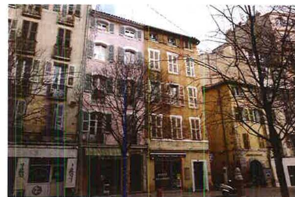
**Le bâti** : Les murs, épais de 45 cm, sont en moëllon de calcaire, recouverts à l'intérieur d'un enduit plâtre de 2 cm. La toiture est en tuile de terre cuite, non isolée. Les fenêtres sont à simple vitrage avec des menuiseries et des volets battants en bois. Le plancher bas est constitué d'une chape béton carrelée sur cave.
