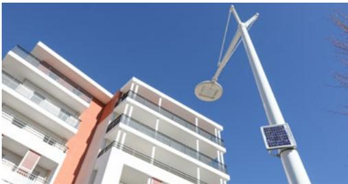
Sur les grands boulevards, les nouveaux luminaires installés à la suite des travaux sont eux aussi intelligents et communicants : il est ainsi possible de les programmer pour une baisse progressive de leur intensité
